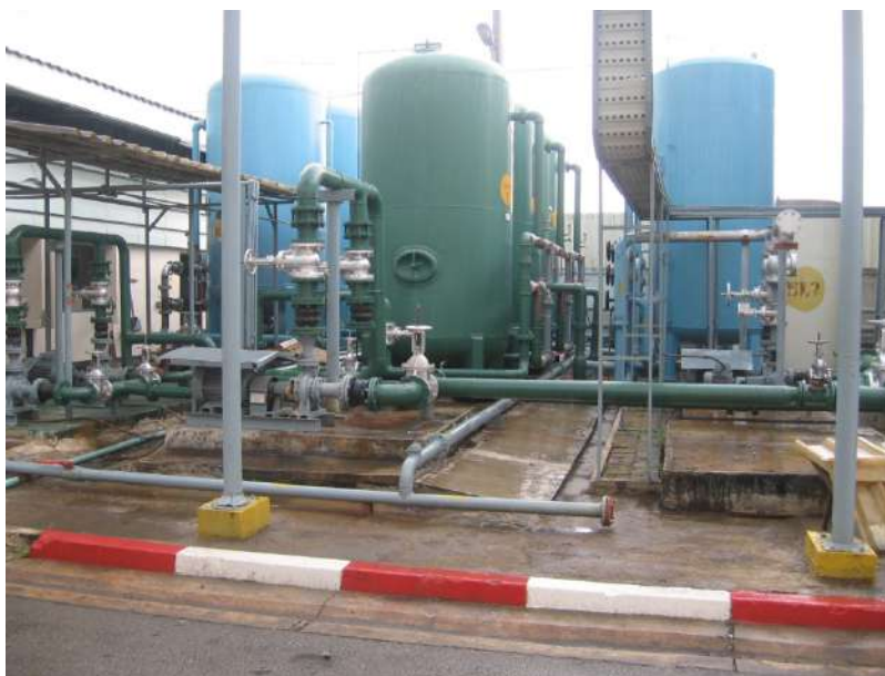
รูปที่ 6.1 ระบบผลิตน้ำอ่อน
