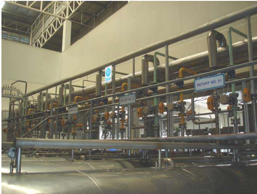
รูปที่ 1.8 ระบบท่อน้ำที่จ่ายเข้าหม้ออบฆ่าเชื้อ
