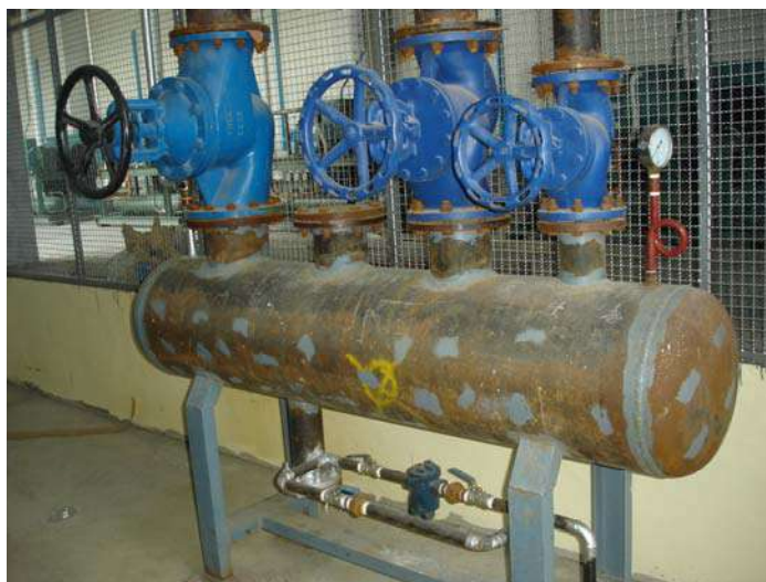
รูปที่ 1.9 ถังพักไอน้ำก่อนการหุ้มฉนวนและกับดักไอน้ำ
