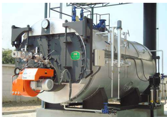
รูปที่ 2.1 หม้อไอน้ำแบบท่อไฟ
