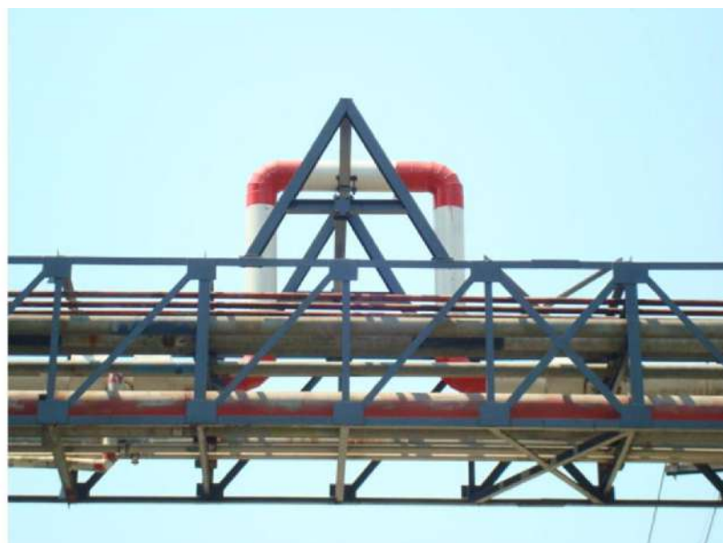
รูปที่ 4.11 แสดงตัวอย่างอุปกรณ์รองรับการขยายตัวและหดตัวของท่อ
