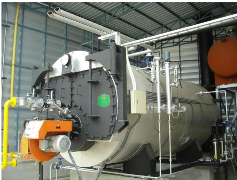
รูปที่ 1.1 หม้อไอน้ำแบบท่อไฟ
