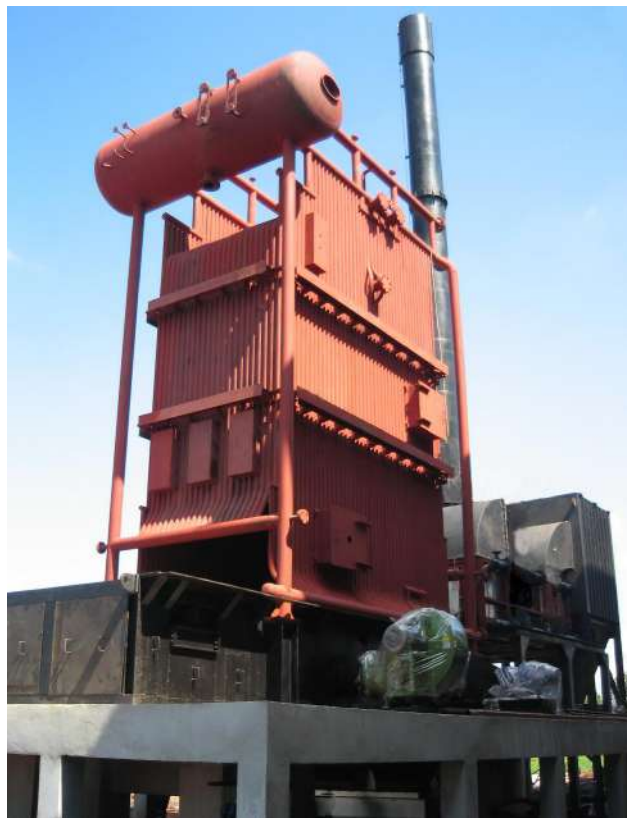
รูปที่ 2.4 หม้อไอน้ำแบบท่อน้ำ
