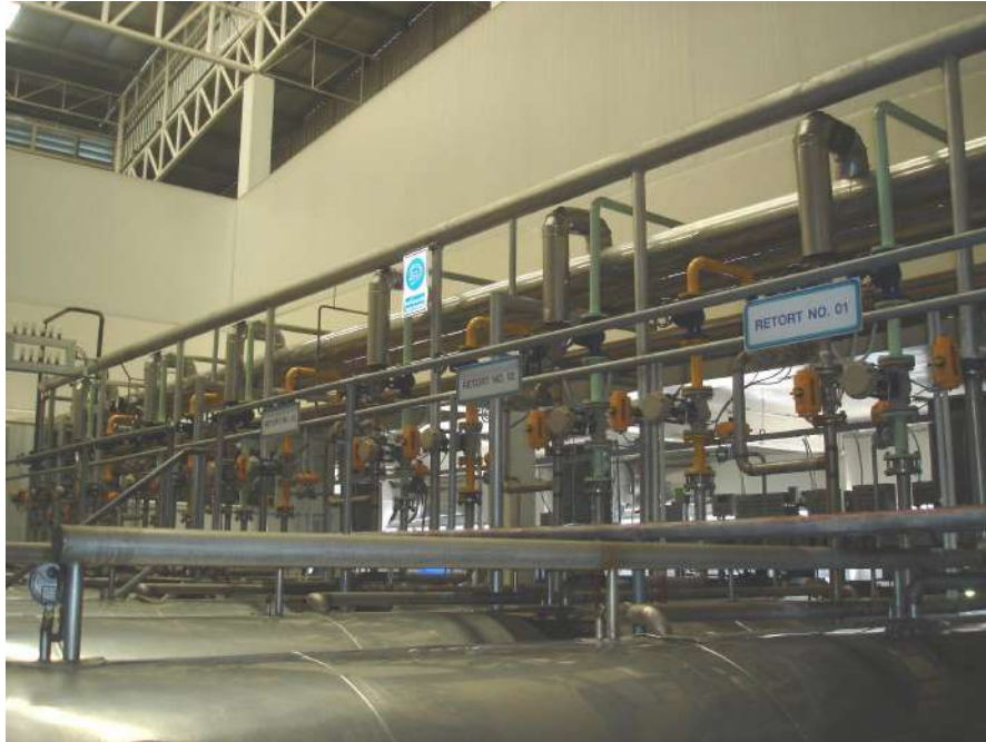
รูปที่ 1.8 ระบบท่อไอน้ำเข้าหม้ออบมาเชื้อ
