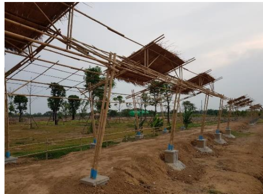
ภาพที่ 15 การทำซุ้มไม้ไผ่และที่กันดินบริเวณซุ้มไม้ไผ่
