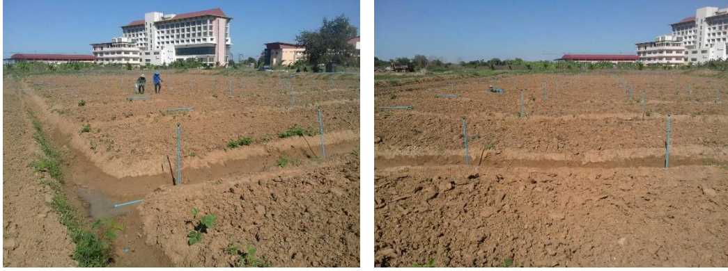
ภาพที่ 4 การยกคันดิน ชุดคลองสร้างระบบระบายน้ำภายในแปลง
