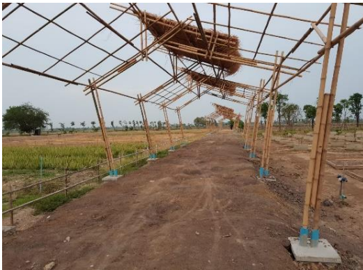
ภาพที่ 15 การทำซุ้มไม้ไผ่และที่กันดินบริเวณซุ้มไม้ไผ่
