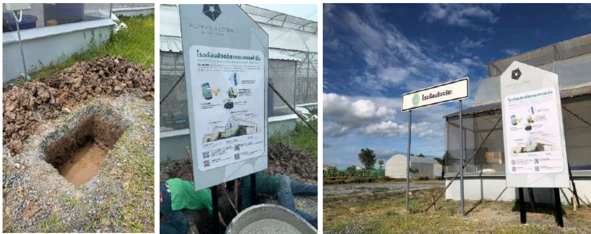
ภาพที่ 50 การติดตั้งป้ายหน้าโรงเรียนอัจฉริยะ
