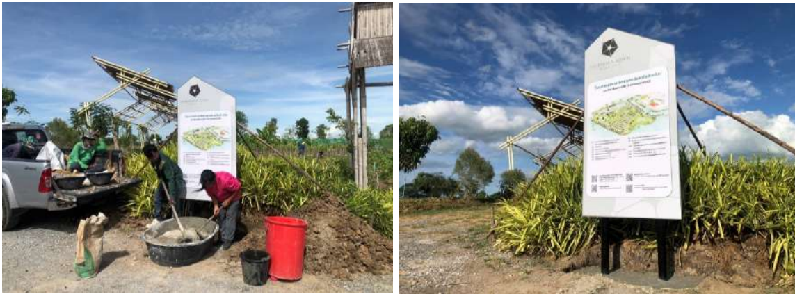
ภาพที่ 49 การติดตั้งป้ายบริเวณด้านหน้าแปลงสาธิตเกษตรปลอดภัยอัจฉริยะ “หอมขจรฟาร์ม”
