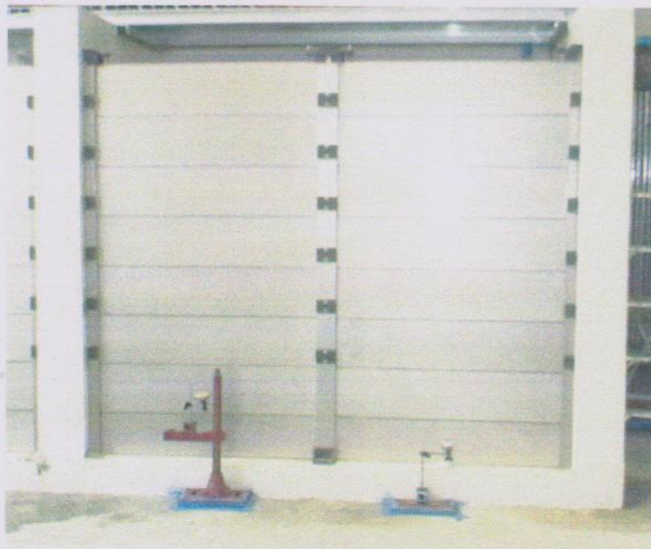
หลังการติดตั้งแผ่นกั้นน้ำอลูมิเนียม
