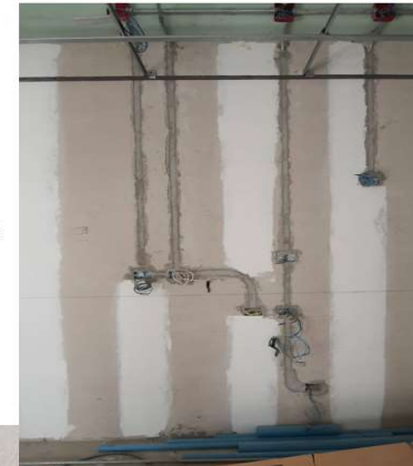
ลักษณะการติดตั้งสวิตช์ไฟฟ้า
