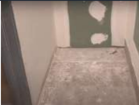
หลังติดตั้งผนังเรียบร้อย
