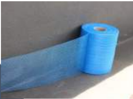
5. หากมีรอยต่อ ให้ติดตาข่ายใยแก้ว RHINOZ ตามแนวรอยต่อ (หากพื้นที่ที่มีการสั่นสะเทือนสูงควรปูทั้งผืน)
