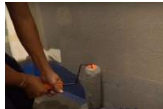
6. ทากันซึม RHINOZ CEMSEAL 501 ทั้งผนังและพื้นให้ทั่วบริเวณทับ 2 รอบ โดยแต่ละรอบ ทั้งให้แห้งสนิท 2-3 ชั่วโมง
