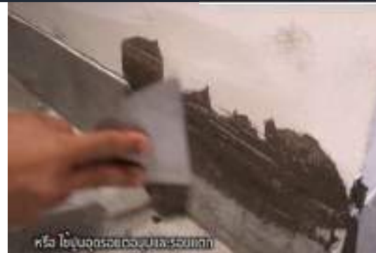
2. ปาดอุดเก็บร่องรอยด้วย RHINOZ Hybrid Joint หรือปูนซีเมนต์ ตามแนวรอยต่อพื้น-ผนัง
