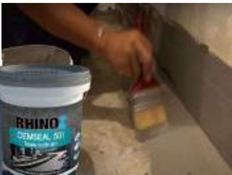
4. หลังจากปั่นผสม RHINOZ CEMSEAL 501 กันซึมตามสัดส่วนที่กำหนดแล้ว ทาด้วยแปรงหรือลูกกลิ้งตามรอยต่อพื้น-ผนัง ทั้งให้แห้งสนิท 2-3 ชั่วโมง
