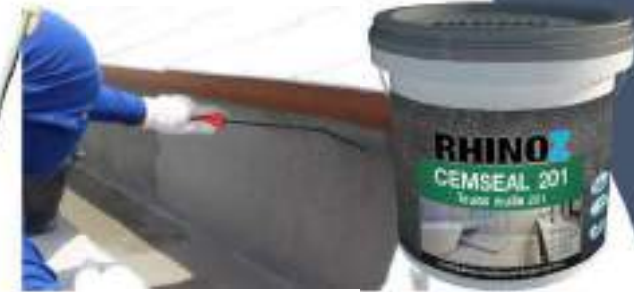
4. เคลือบชั้นแรกโดยทาด้วยแปรง หรือลูกกลิ้ง ทิ้งให้แห้งก่อนเคลือบชั้นที่ 2
