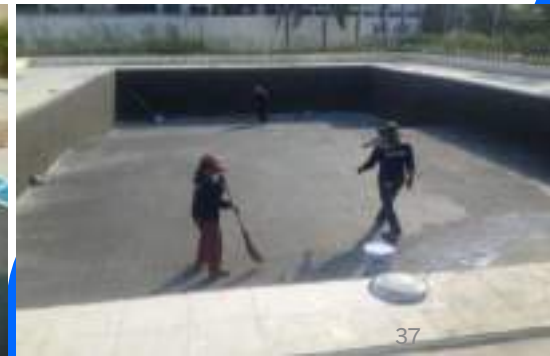
งานปรับปรุงสระว่ายน้ำรั้วซีม โดยไม้อู้อกระเบื้องเดิมออก
