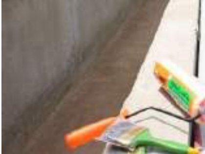
1. ทำความสะอาดพื้นผิว ให้ปราศจากฝุ่น *หากมีรอยร้าวหรือรอยแตกควรซ่อมแซมก่อน
