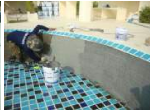
งานปรับปรุงสระว่ายน้ำรั้วซีม โดยไม้อู้อกระเบื้องเดิมออก
