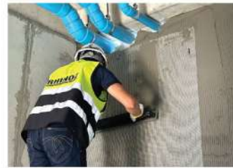
3. ไล่ Fiberglass Mesh Tape ช่วยเสริมความแข็งแรงยึดเกาะ และใช้เกรียงหริพิเศษ กดทับให้ตาข่ายเข้าไปในซีเมนต์ ฉาบจบความหนา 2-3 mm.
