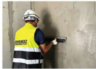
2. ใช้เกรียงหริพิเศษปรับระดับซีเมนต์ตามระดับร่องพินของเกรียงหริพิเศษ (0/6 mm.)
