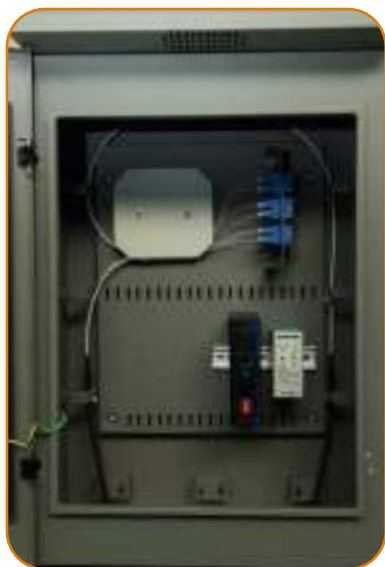
SP-2305 ค่าติดตั้งอุปกรณ์ F.O. ในตู้ CCTV Cabinet (Outdoor) พร้อมจัดสาย
