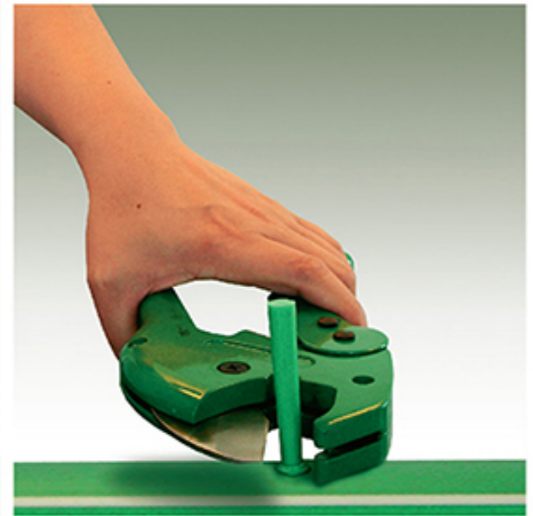
ตัดท่อส่วนที่เหลือออก
