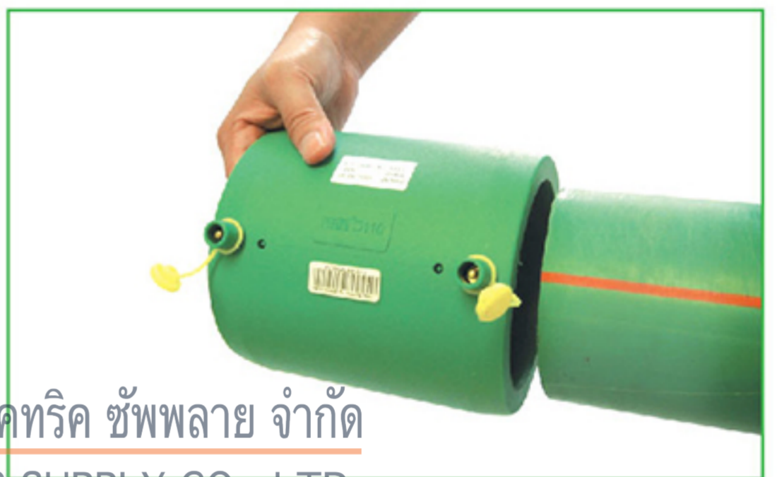
4 นำท่อสวมเข้ากับข้อต่อทั้งสองด้าน ดันจนถึงจุดบวม
