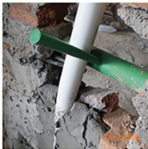
ท่อซ่อมที่เชื่อมรูรั่วแล้ว
