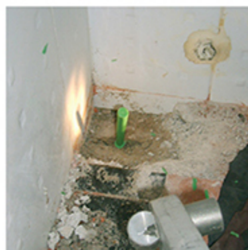
ท่อซ่อมที่เชื่อมรูรั่วที่พื้นแล้ว
