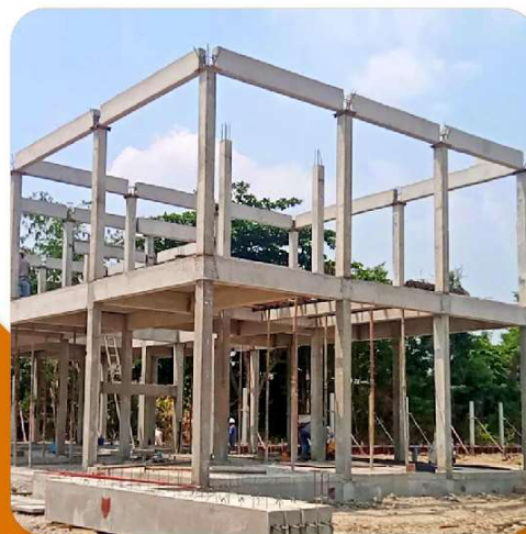
ติดตั้งโครงสร้างคาน-เสาสำเร็จรูป
