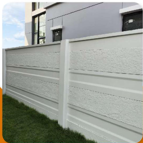
ติดตั้งรั้วคอนกรีตสำเร็จรูป
