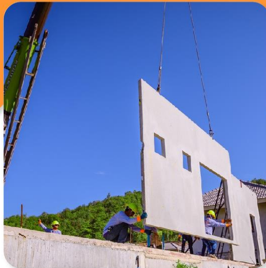
ติดตั้งผนังสำเร็จรูป
