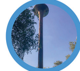
○ ระบบน้ำชุมชน
