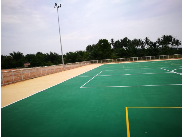
ลานกีฬาคอนกรีตเคลือบผิวและตีเส้น 30*50 เมตร (มีรั้วรอบ สูง 1 เมตร)
