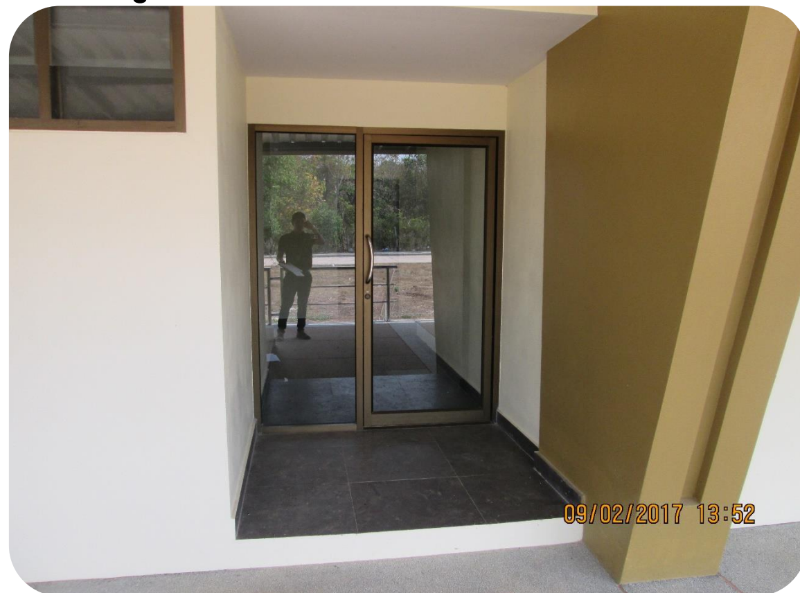
การก่อสร้างจริง
