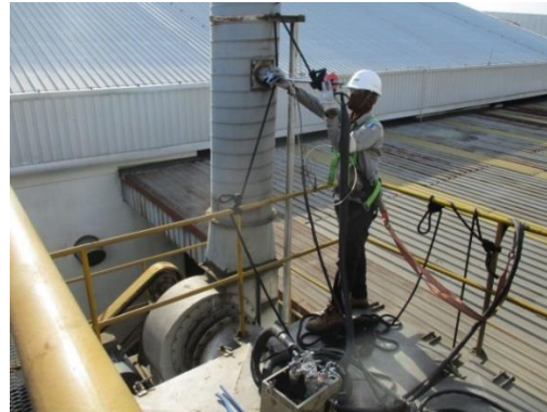
ตรวจวัดอากาศในปล่องระบาย
