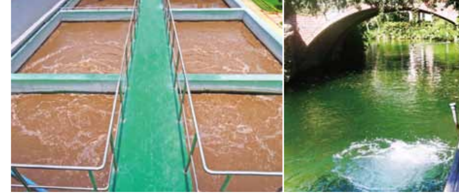
การบำบัดน้ำเสีย: ติดตั้งที่ความลึก 4.5 เมตร
