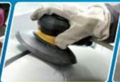
Cleaning/ขัดทำความสะอาด
