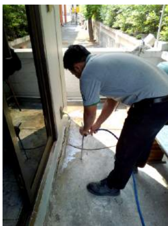
การป้องกันและกำจัดปลวก ระบบเจาะปักอัดน้ำยา
