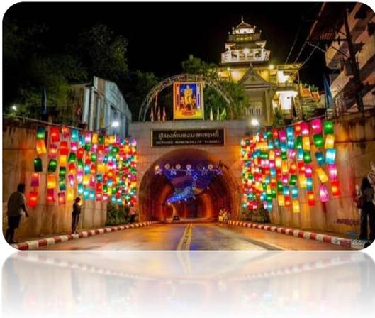
タイ初の山を抜ける車のトンネルです。幅9メートル、高さ7メートルの鉄筋コンクリートで通勤者を容易にするために建てられるために建てられ、トンネル全体の長さは約273メートルです。2001年1月1日に正式にオープンしました。ベートンモンコンリットトンネルのハイライトは、一日中、車が入り出て、トンネル内を歩き回ることが
