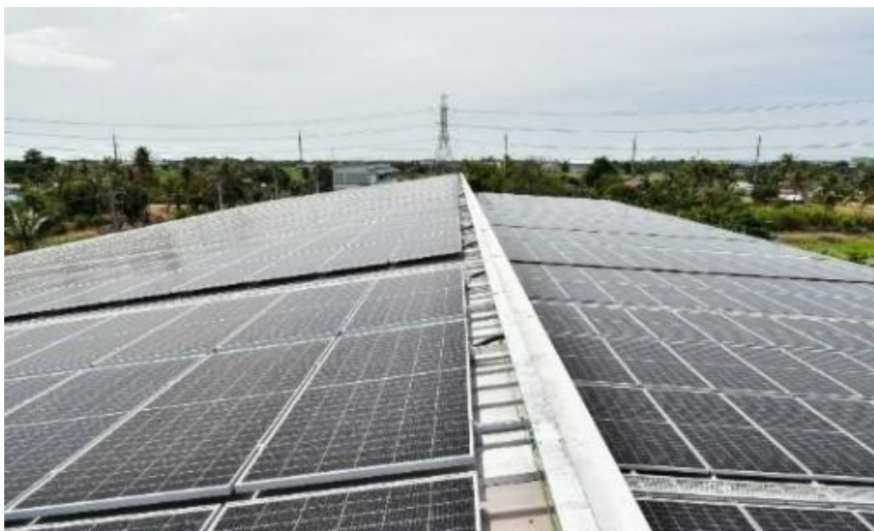
โครงการติดตั้งระบบไฟฟ้าพลังงานแสงอาทิตย์
