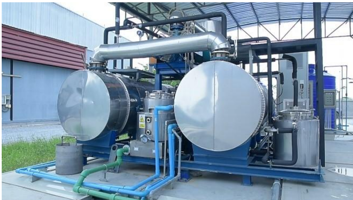
ระบบบำบัดน้ำเสียแบบ
